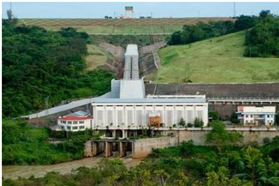
Nhà máy thủy điện Thác Mơ
