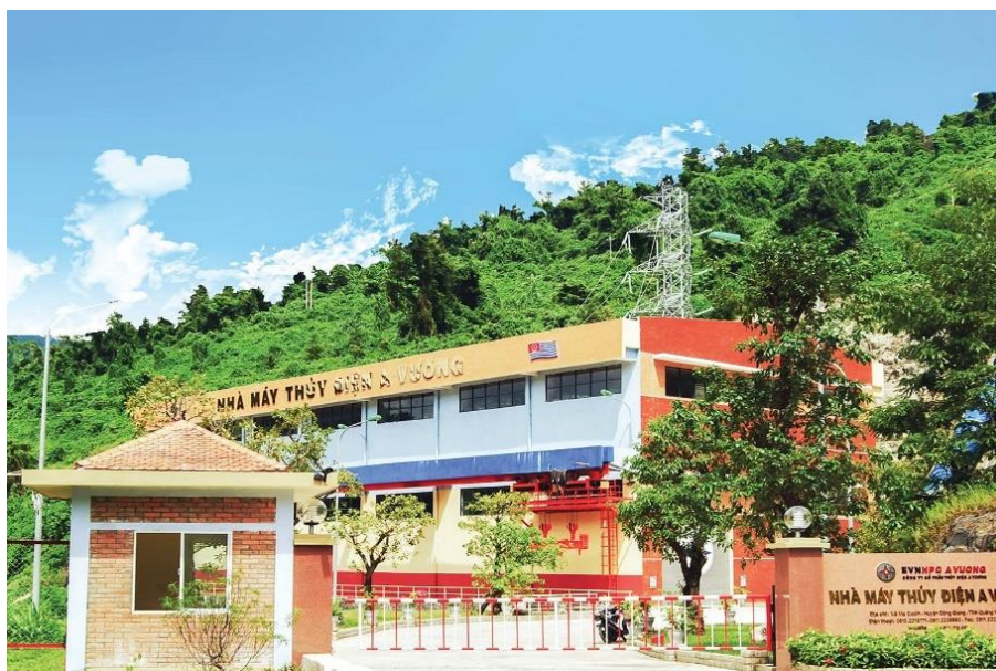
Nhà máy Thủy điện A Vương
