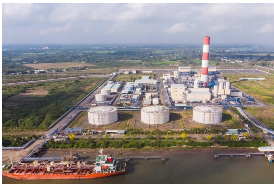
Nhà máy Nhiệt điện Ô Môn
