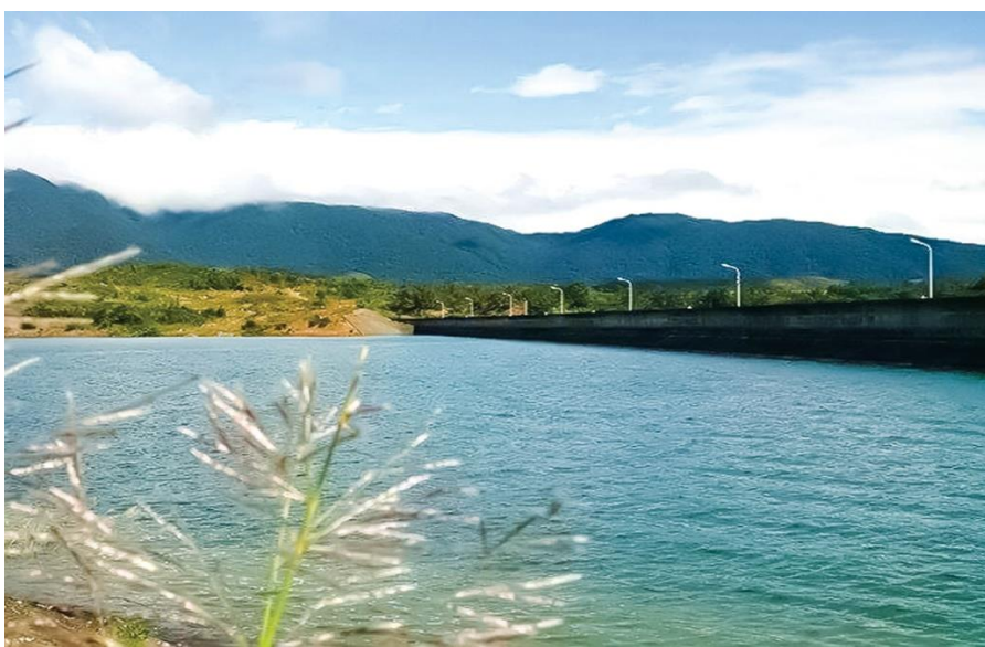
Lò hồ Thủy điện Quảng Trị
