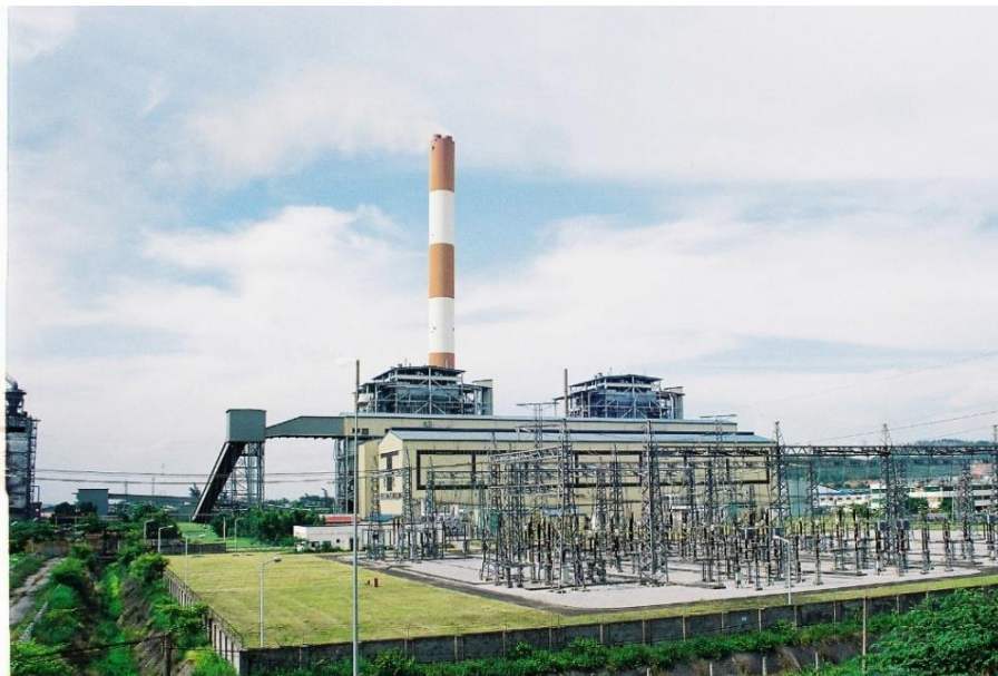
Nhà máy Nhiệt điện Phả Lại
