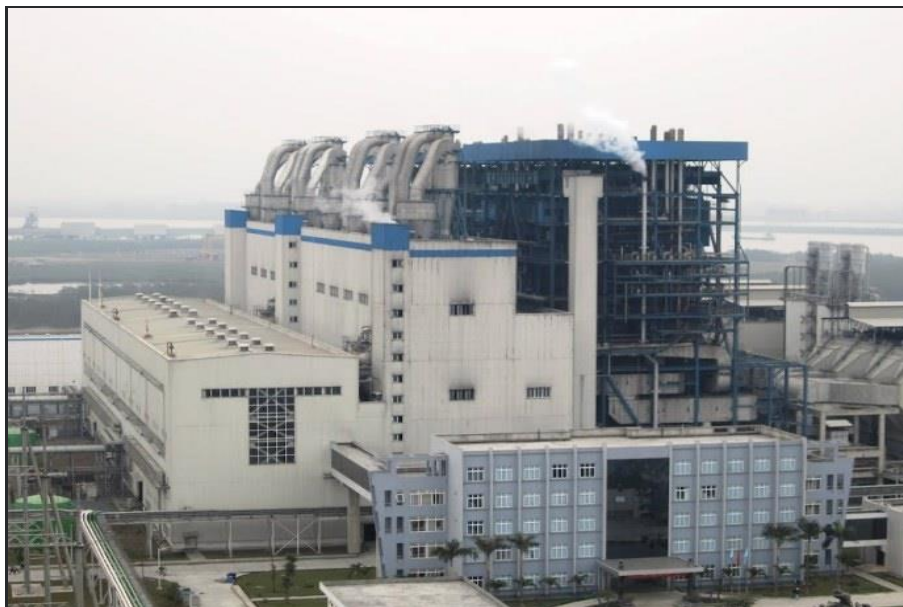
Nhà máy Nhiệt điện Hải Phòng
