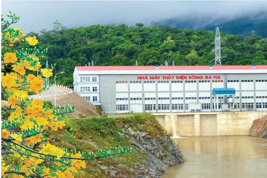
Nhà máy thủy điện Sông Ba Hạ
