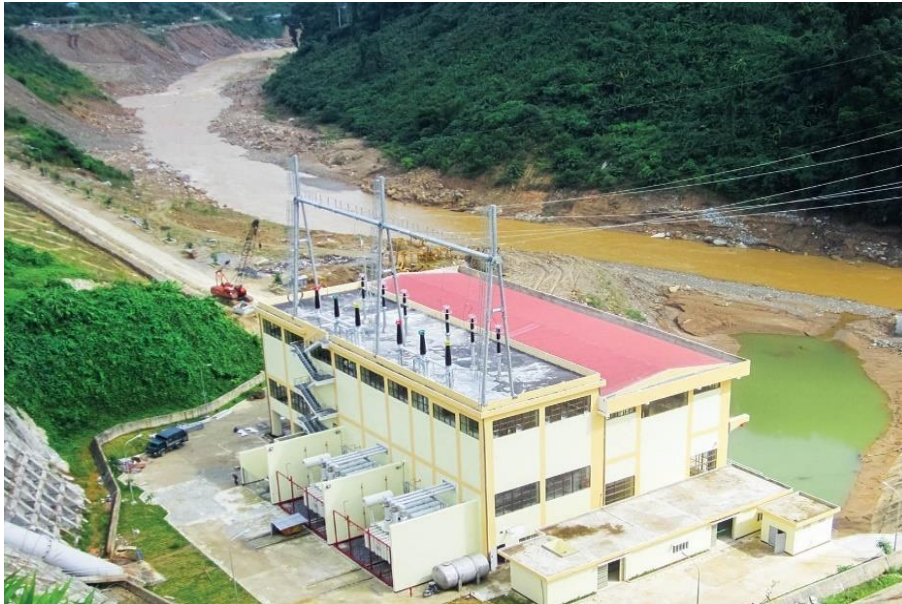
Nhà máy Thủy điện Sông Bung 4
